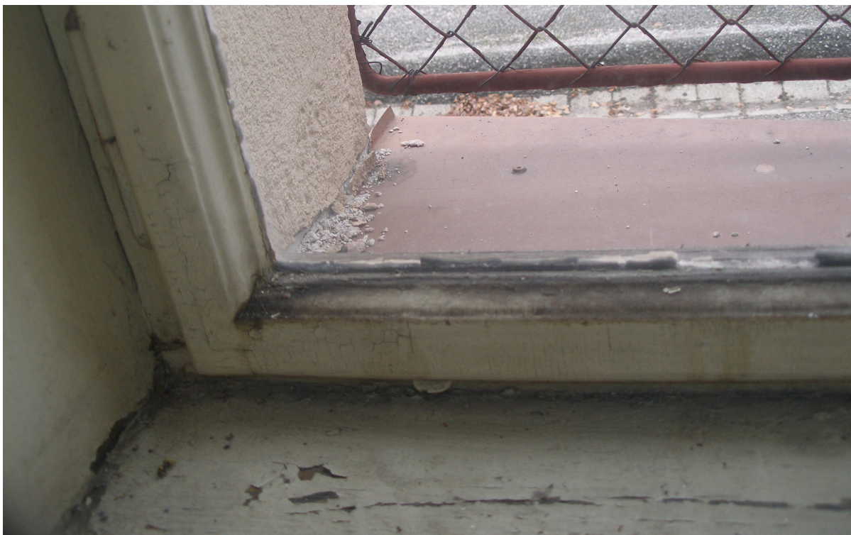
ŠESTIKŘÍDLOVÁ OKNA TĚLOCVIČNY (č.162,163) - SKUPINA 3 - POŠKOZENÍ VNĚJŠÍCH RÁMŮ
