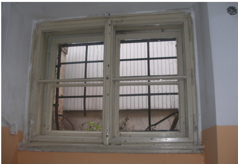
DVOUKŘÍDLOVÉ OKNO (č. 010) - SKUPINA 4 - CHYBĚJÍCÍ KOVÁNÍ, PEVNÉ ZAJIŠTĚNÍ VRUTY
