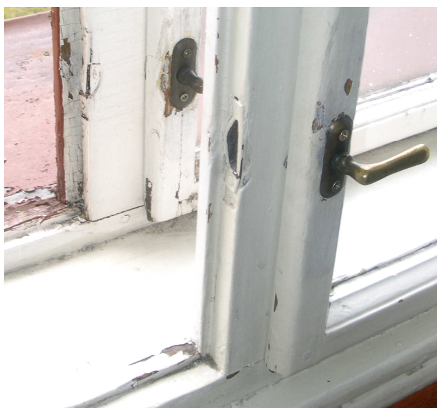
POŠKOZENÍ V MÍSTECH KOVÁNÍ, NEVHODNÉ VRUTY OPRAVOVANÝCH PŮLOLIV, MEZERA MEZI RÁMEM A KŘÍDLEM
