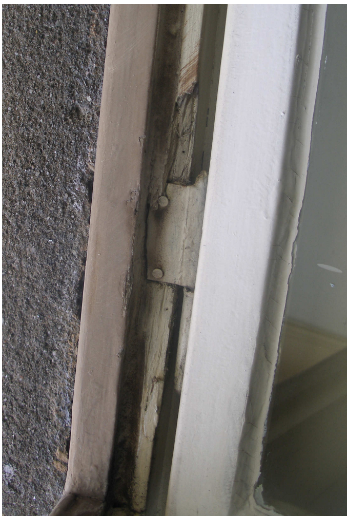
ŠESTIKŘÍDLOVÉ OKNO (č. 341) - SKUPINA 3 - ODŠTÍPLÉ DŘEVO RÁMU V MÍSTĚ PANTU
