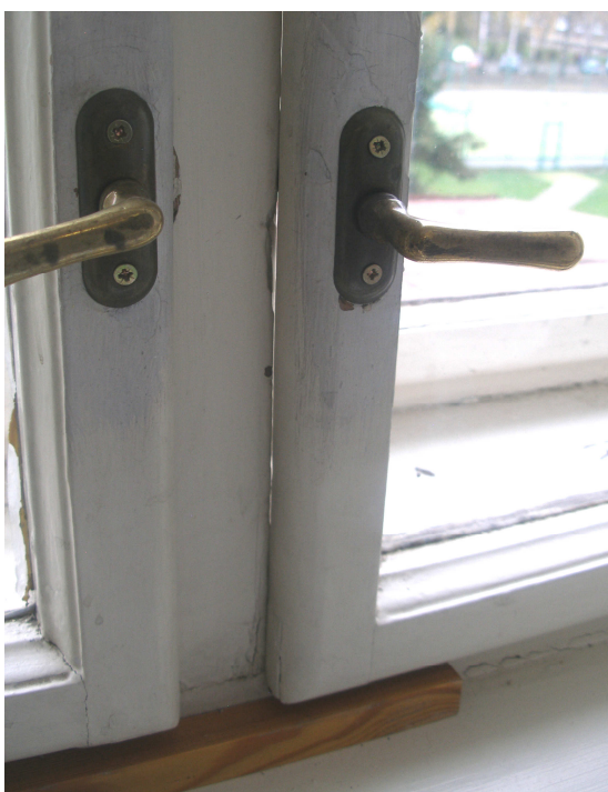
ŠESTIKŘÍDLOVÉ OKNO (č. 207) - SKUPINA 4 - POŠKOZENÍ VNĚJŠÍCH I VNITŘNÍCH RÁMŮ A ŠPALET, NEFUNKČNÍ KOVÁNÍ, ZKŘIVENÁ VĚTŠÍ ČÁST KŘÍDEL
