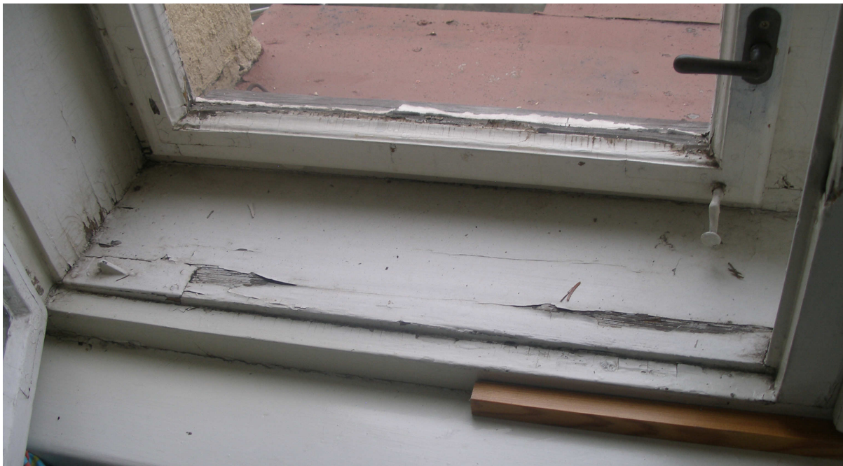
ŠESTIKŘÍDLOVÉ OKNO (č. 207) - SKUPINA 4 - POŠKOZENÍ VNĚJŠÍCH I VNITŘNÍCH RÁMŮ A ŠPALET, NEFUNKČNÍ KOVÁNÍ, ZKŘIVENÁ VĚTŠÍ ČÁST KŘÍDEL
